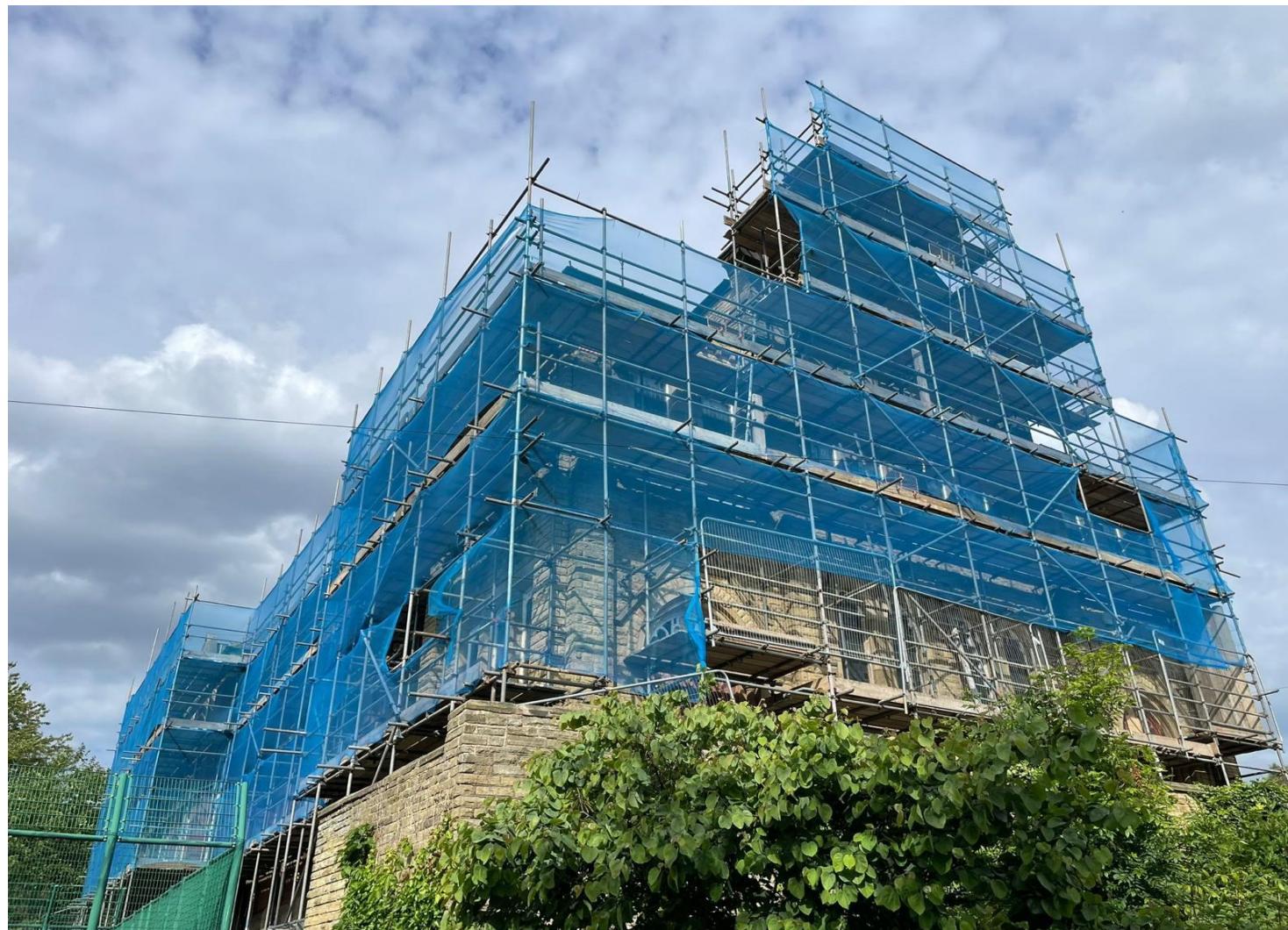
外墙翻新（第二阶段）
